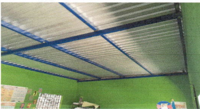
Foto 3: CONCLUIDA LA SUSTITUCIÓN DE LÁMINA, POR LÁMINA TROQUELADA ALUZINC.
