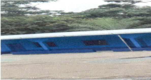
Foto1: FINALIZADA LA SUSTITUCIÓN DE LÁMINA, POR LÁMINA TROQUELADA ALUZINC
