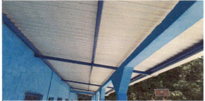
Foto 2: CULMINADA LA SUSTITUCIÓN DE SOPORTE DE MADERA POR METAL
