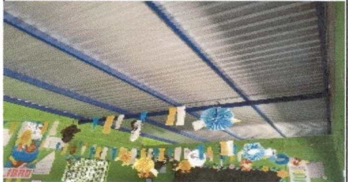
Foto 4: FINALIZADA LA SUSTITUCIÓN DE SOPORTE DE MADERA POR METAL.
